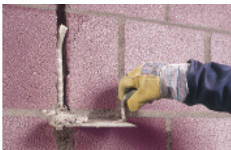
Corretto riempimento delle tracce impiantistiche.
