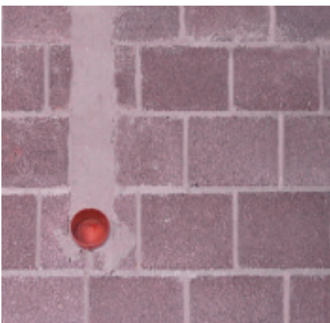
Parete divisoria con ponte acustico dovuto alla presenza di cavedio impiantistico.
