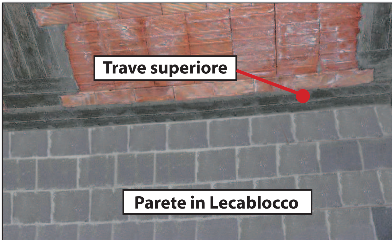
Foto 1 Nodo tra parete divisoria e solaio superiore.
