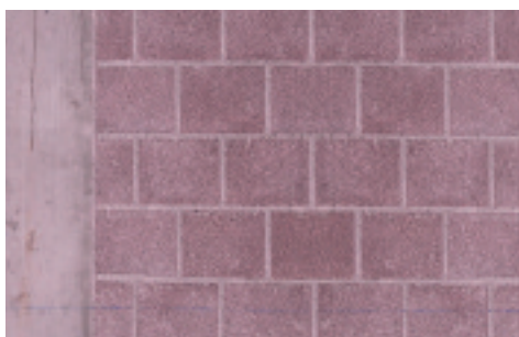
Giunto tra pilastro e muratura.
